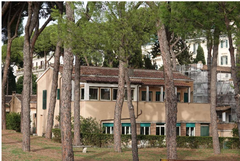
Pavillon d'about – Vue des logements I au rez-de-chaussée et H à l'étage
