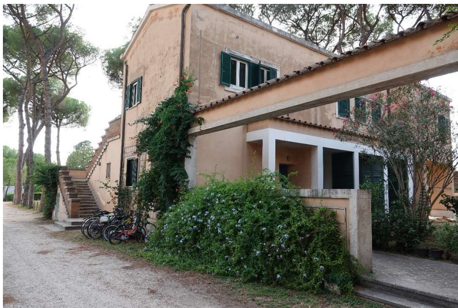
Pavillon d'about - Vue depuis la voie de Porta Pinciana
