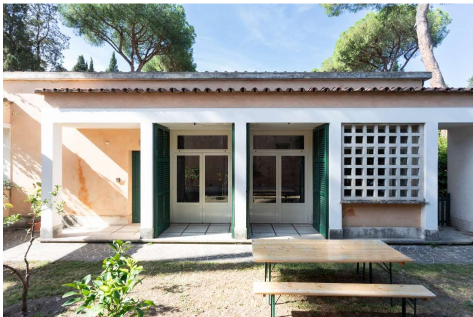
Padiglione con tre portefinestre e una grata – Facciata nord
