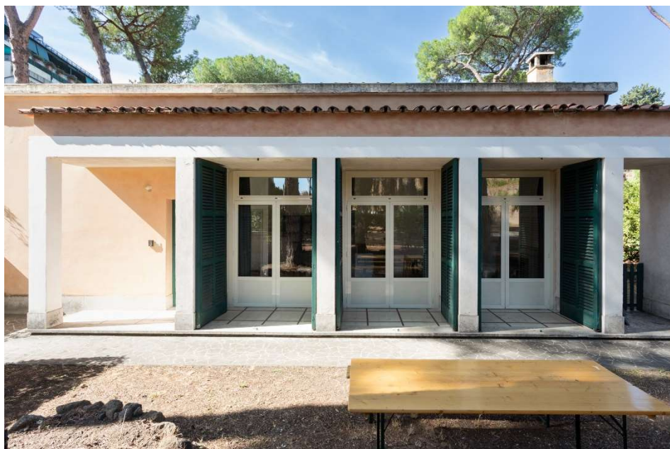
Padiglione con due portefinestre – Facciata nord
