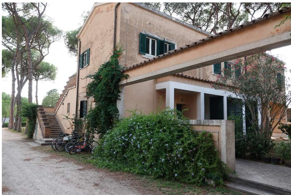
Padiglione terminale - Vista dalla via Porta Pinciana
